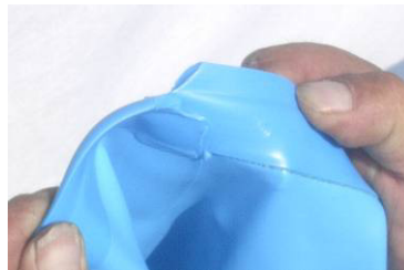
Keilförmiger Zuschnitt Folienecke, mit Japanmesser oder Schere, zusätzlich bitte diese Ecken mit chlorbeständigem Silikon in der Ecke verkleben
